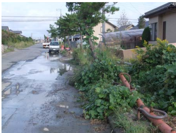
II-5. 傾いた住宅の外構部
