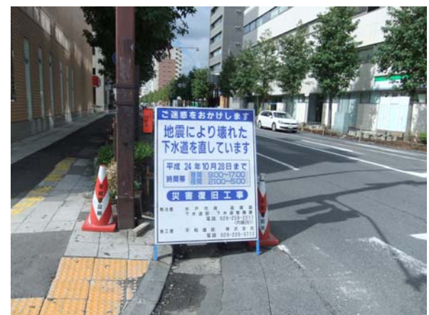
I-6. 下水道復旧工事
