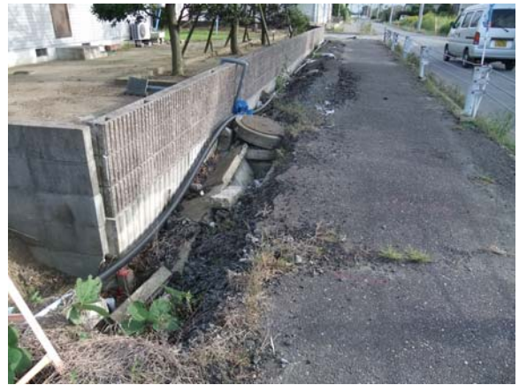
II-2. 仮設管による応急処置
