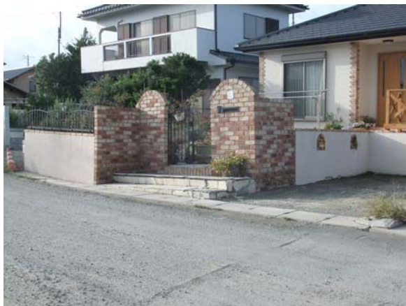
II-3. 住宅外構部の損傷
