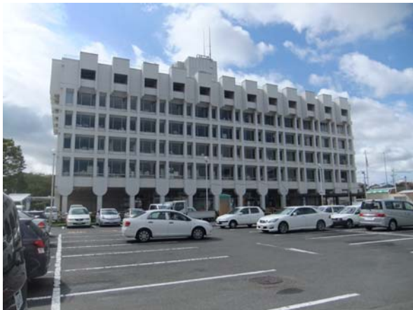
I-1. 使用不能となった水戸市役所
