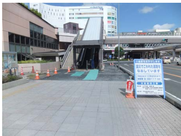
I-5. 駅前歩道は復旧工事中
