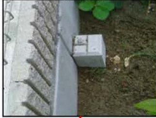
境界杭確認有り
