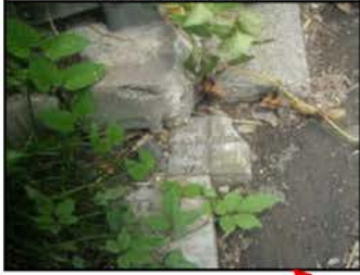
境界杭確認有り
